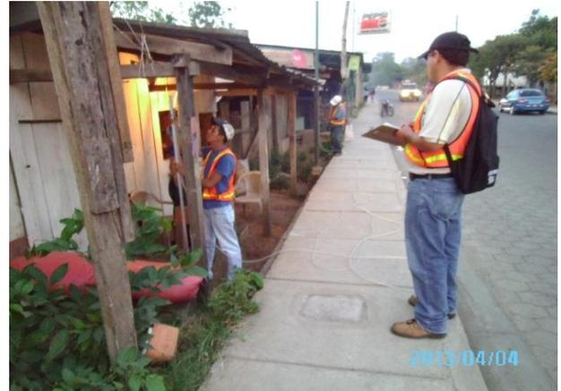
Levantamiento topográfico con nivel de manguera
