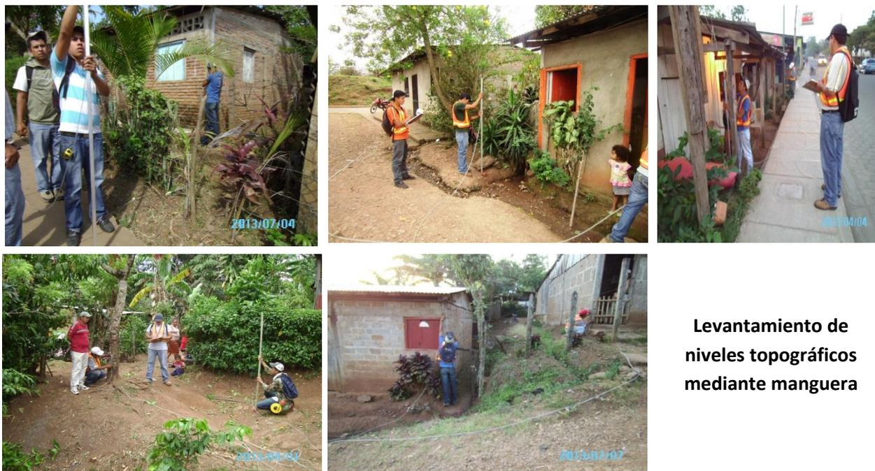
**Levantamiento de niveles topográficos mediante manguera**
